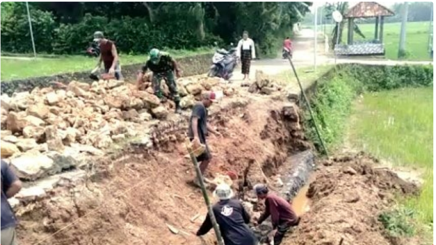
Karya Bakti pembuatan plengsengan penahan jalan
